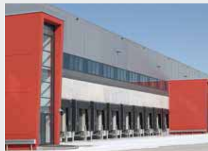
Centrum logistyczne Immogate, Monachium
